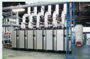
貫流ボイラー（大阪工場）
