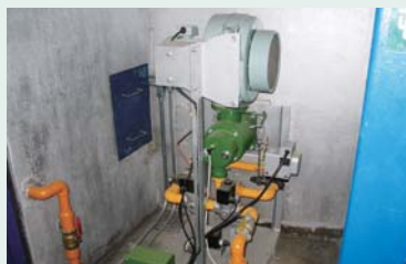
ガス対応バーナー（大阪工場）
