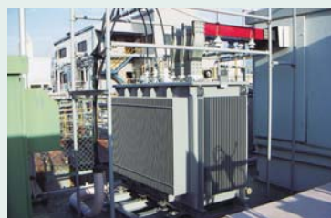
高効率変圧器(大阪工場)
