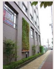
南館西側の壁面緑化
