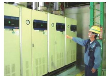
週末の運転を停止した貫流ボイラー
