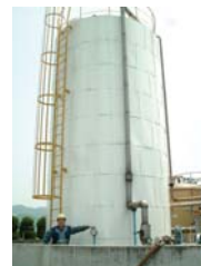
遮熱塗料を塗ったタンク
