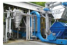
汚泥処理設備
