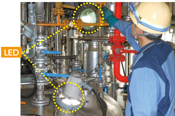
反応釜のLED照明(水島工場)
