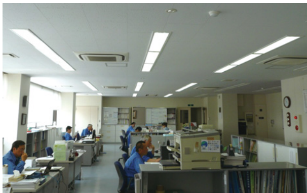
事務所天井LED照明(パルノックス)
