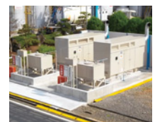
緊急設置した自家発電機
