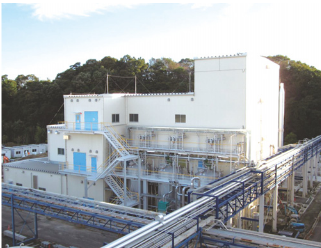
プラント内受入れタンク
