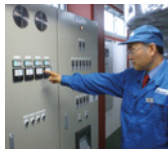
インバーター導入の空調機
