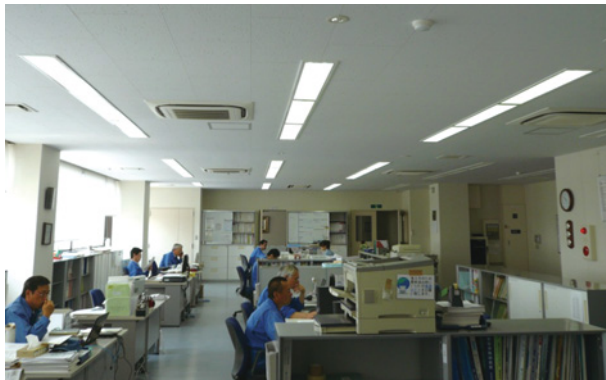
事務所天井LED照明(パルノックス)
