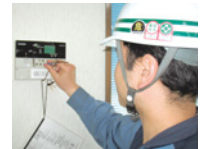
最大電力調節器(デマンドコントローラー)の制御
