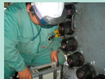
適切に均一に締め付けるため、超音波法によるボルト締結管理を採用
