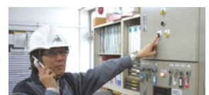
設備異常音声発報システム
