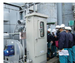
触媒酸化式脱臭装置の操作訓練風景
