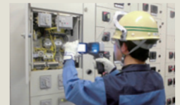
電気設備の診断
