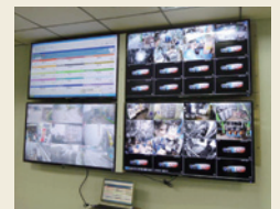
管理部に設置した大画面情報モニター
