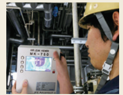
エアリークビューアーを用いたエア漏れの点検
