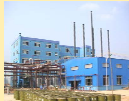
ロジン精製プラント外観
