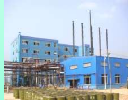
ロジン精製プラント外観
