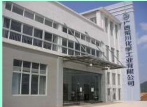
事務所棟外観
