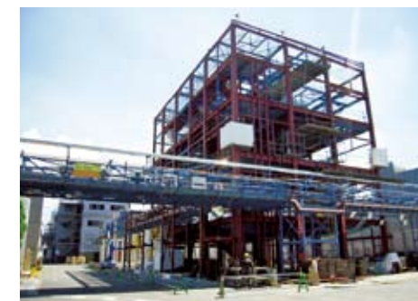
大阪工場 製造設備新設工事
