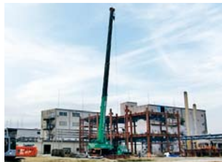
小名浜工場 製造設備新設工事
