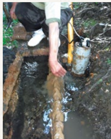
●「ガンゼキ」を使って水漏れしている部分を修理。4時間ほどで徐々に固まります
