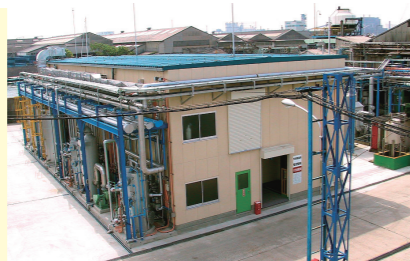
FP設備全景
