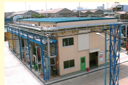
FP設備全景
