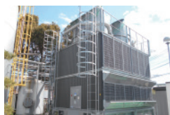
クーリングタワーの更新
