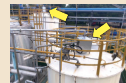
甲類タンク上部VOCガス捕集力バー設置
