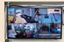
流出発見用モニターの設置
