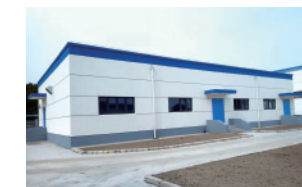
新制御室完成(2024年11月)
