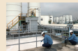
曝気槽(微生物処理槽)の点検整備
