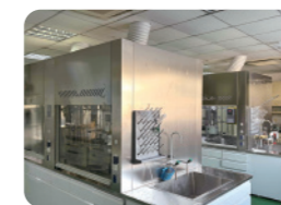
実験室の排気システムを更新
