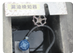
漏洩検知器の設置
