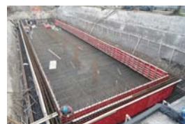
工事中の事故池
