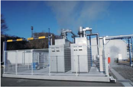
LNGボイラー (LNG:液化天然ガス) (小名浜工場)
