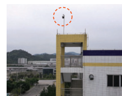
排煙を監視する高所カメラ
