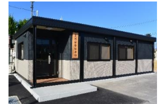
荒川安全伝承館の設置
