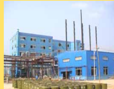
ロジン精製プラント外観
