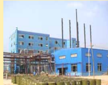
ロジン精製プラント外観
