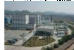
広西梧州荒川化学
