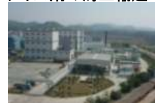
広西梧州荒川化学
