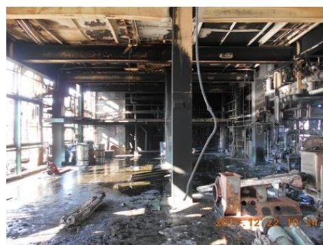
図 105 熱媒油で汚れた2階床面
