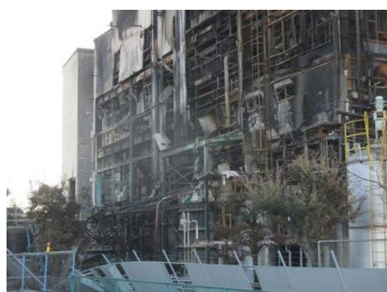
図 95 発災後の製造棟北壁
