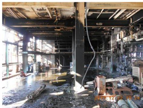
図 80 熱媒油で汚れた 2階床面
