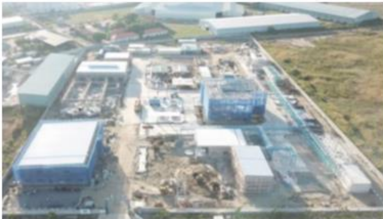
建設中の荒川ケミカルベトナム社
